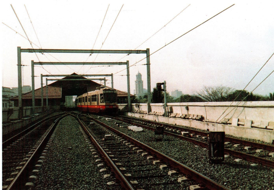
1. Zicht van de installatie.
